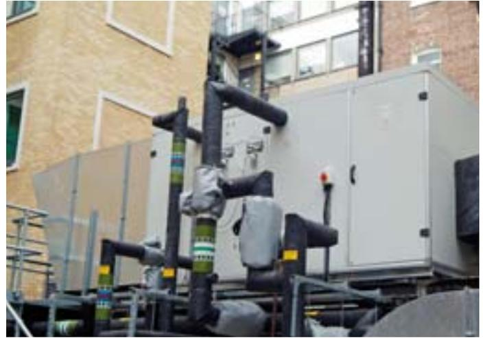
**Anschluss an Kaltwasserregister von RLT-Anlagen**
