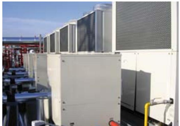
**Austausch von Flüssigkeitskühlern Kaltwassererzeugung für Ventilator-Konvektoren im Austausch gegen Flüssigkeitskühler**
